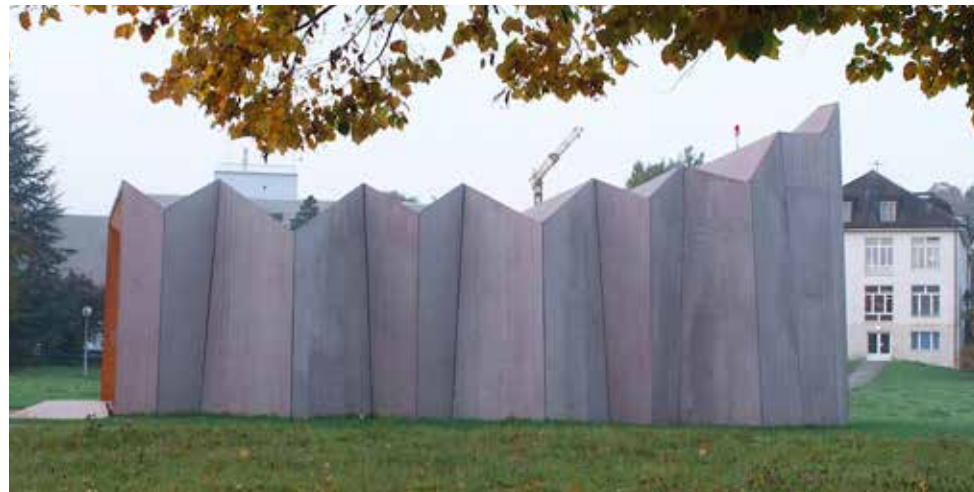
Ci-contre : la chapelle Saint-Loup de Pompaples (2008) interroge les structures plissées. De très minces plaques de bois contrecollé (CLT) sont mises en œuvre à la manière des origamis japonais.
